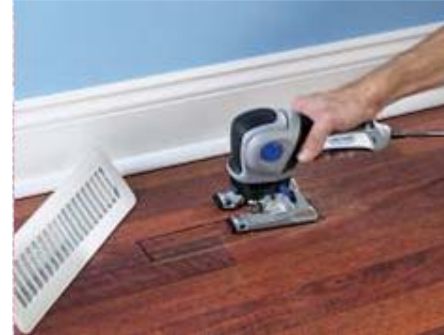
Guri de ventilare
